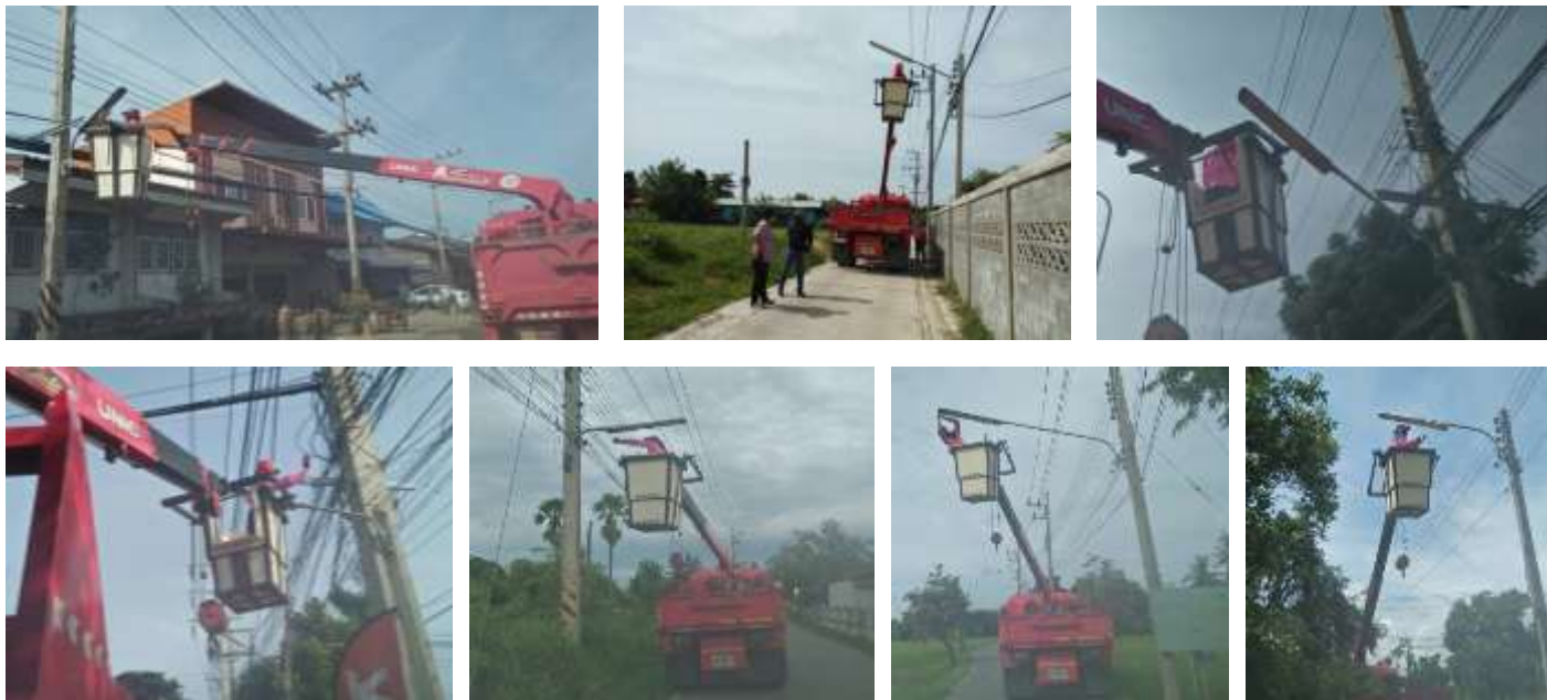
เทศบาลตำบลลาดแค ได้ดำเนินการซ่อมแซมไฟฟ้าส่องสว่างภายในเขตเทศบาลตำบลลาดแค
